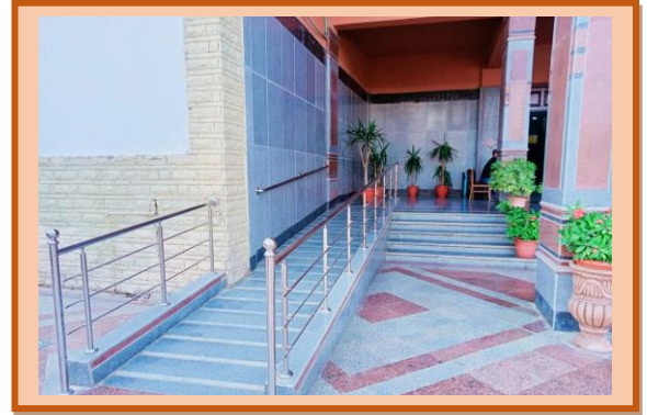
تأهيل المداخل باستخدام رمبات لتوفير سبل الاتاحة للطلاب ذوي الاعاقة بمبنى رئاسة الجامعة
